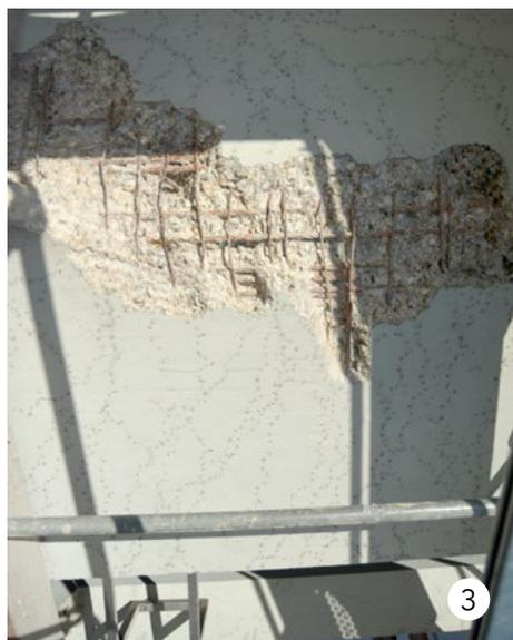
Der Nahbereich um den Turm wurde sofort abgesperrt. Das Geläut wurde zunächst reduziert auf eine einzelne der fünf vorhandenen Glocken. Inzwischen schweigen die Glocken ganz, weil die Schwingungen den Turm zusätzlich schädigen.
